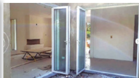
Esquadrias em alumínio instaladas na região
