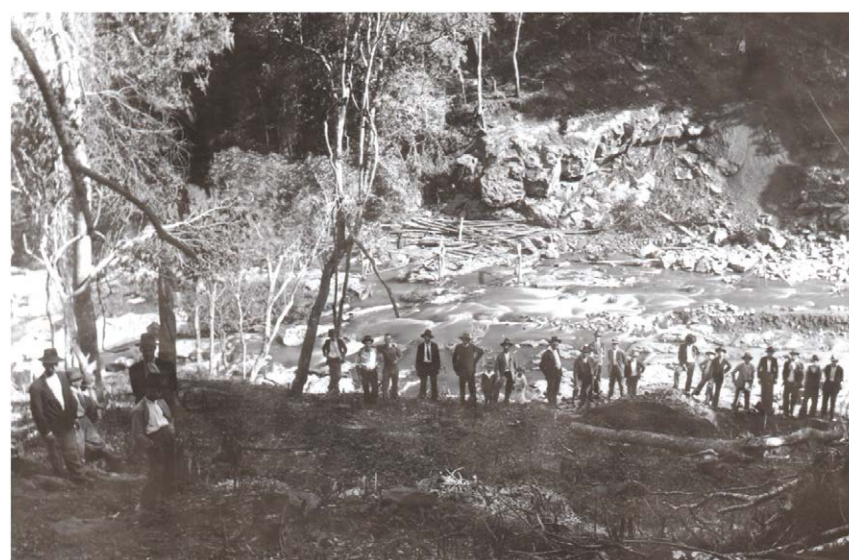
Local da construção da barragem. Imagens do acervo municipal de Santa Maria do Herval.
